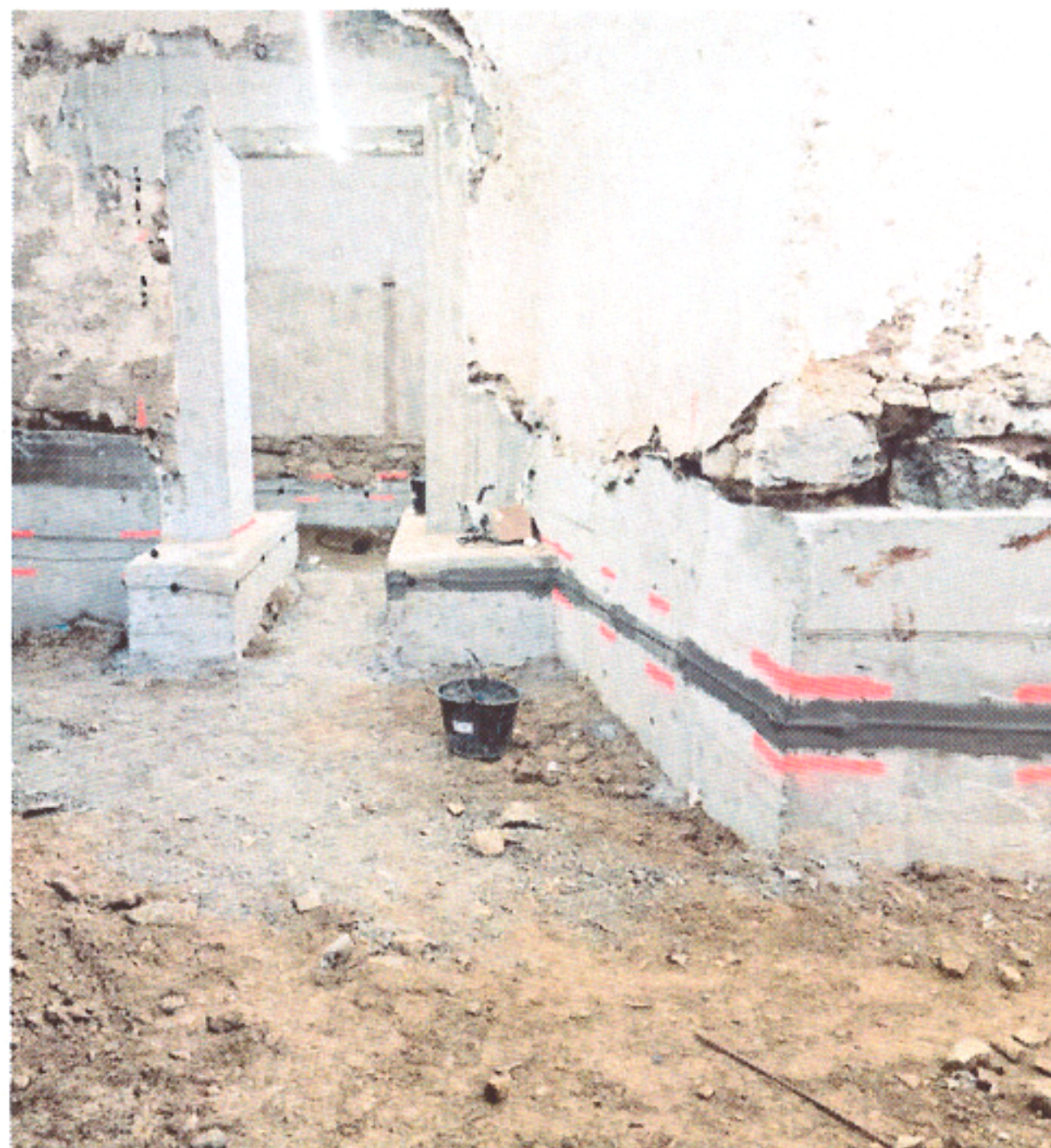
ob ein Bruchsteinmauerwerk oder eine Unterfangung aus Beton, das Anbringen des Plus Pols ist kein Problem
