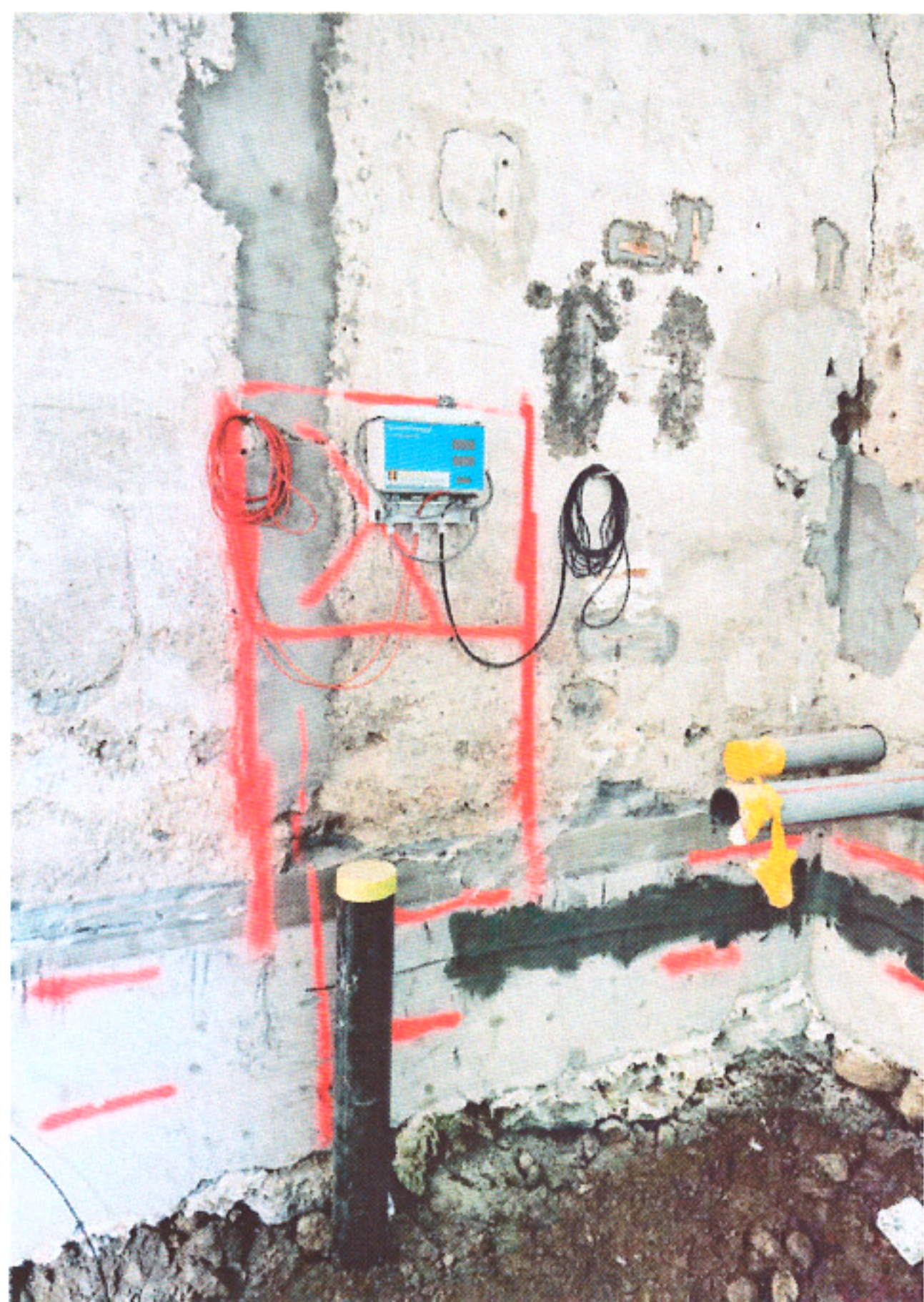
ob ein Bruchsteinmauerwerk oder eine Unterfangung aus Beton, das Anbringen des Plus Pols ist kein Problem
