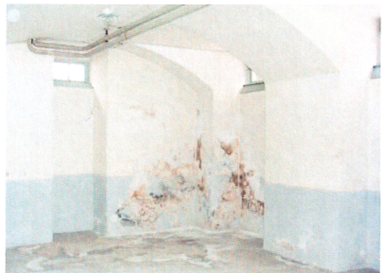
typisches Beispiel von aufsteigender Feuchtigkeit in einem Bruchsteinmauerwerk
