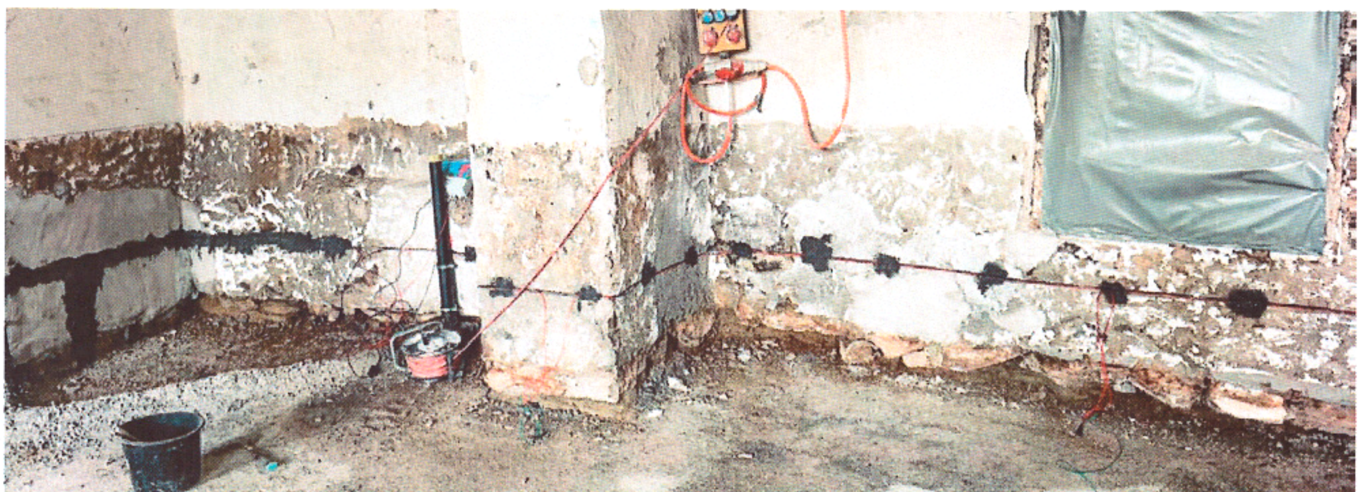
typisches Beispiel von aufsteigender Feuchtigkeit in einem Bruchsteinmauerwerk
